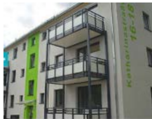
Abb. 49: Gebäude nach Sanierung
