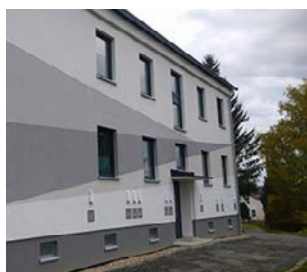
Abb. 38: Dezentrale Lüftungseinheiten integriert in Dämmelemente
