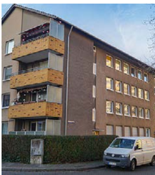
Abb. 65: Gebäude vor der Sanierung
