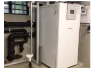
Abb. 51: Sole-Wasser-Wärmepumpe
