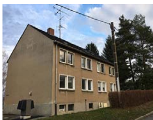
Abb. 39: Gebäude vor Sanierung mit Wärmepumpen-Außenluft-Einheit
