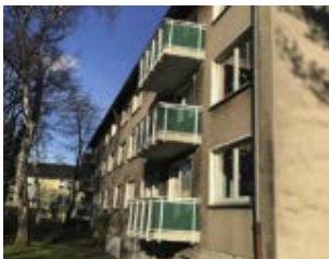
Abb. 48: Gebäude vor Sanierung
