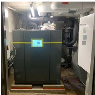
Abb. 57: Wärmepumpe
