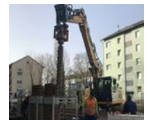
Abb. 54, 55, 56: Gebäude (li.) aus der Vogelperspektive, das angebaute Müllhaus mit Außenlufteinheit auf der Giebelseite (Mitte) und Montage der Erdwärmesonden (re.)
