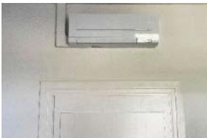
Abb. 41: Inneneinheit des Splitgeräts
