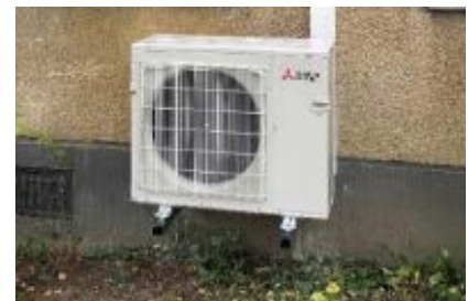
Abb. 43: Einzelnes Außengerät
