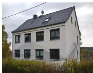
Abb. 40: Gebäude nach Sanierung
