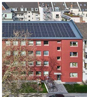
Abb. 66: Gebäude nach der Sanierung
